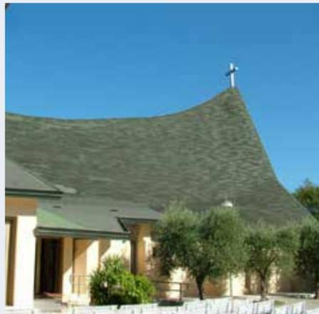
Il tetto realizzato con lastre bitumate è stato rimosso e smaltito per procedere con la posa di guaina microforata traspirante e travetti per garantire la ventilazione del tetto. Infine sono stati posizionati i materiali isolanti e la copertura in rame grazie al lavoro di operai specializzati in grado di lavorare in condizioni difficili.
