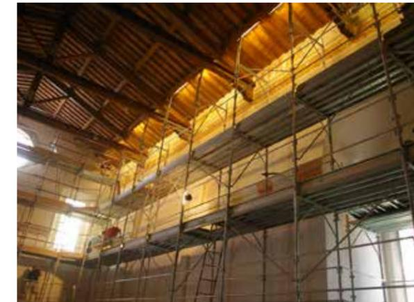
La rimozione del controsoffitto che schiacciava la percezione della navata snaturandola è stata fondamentale per riportare alla luce la parte superiore con le capriate lignee originali e il ciclo di affreschi sulle pareti datati 1536.
