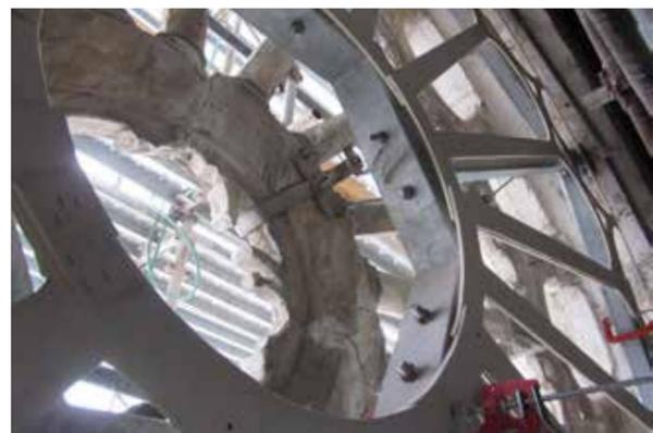
*Il calco e i rilievi del rosone in pietra, la ricostruzione in laboratorio e la prova sul luogo delle sagome in legno prima della progettazione finale del telaio.*
