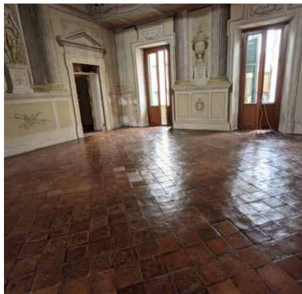
*Restauro del pavimento in cotto del salone e smontaggio e rifacimento di parte del pavimento ligneo della sala adiacente.*
