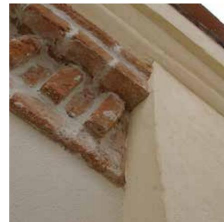
Dettagli della demolizione dell'intonaco e del suo ripristino sulla facciata.
